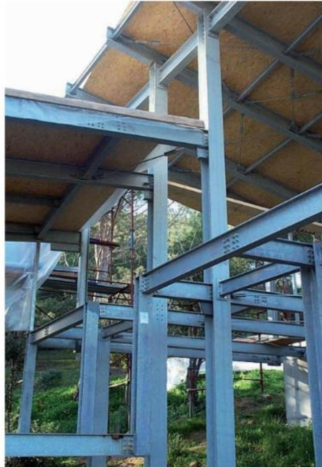
Telaio e travi di solaio in acciaio zincato a caldo.
